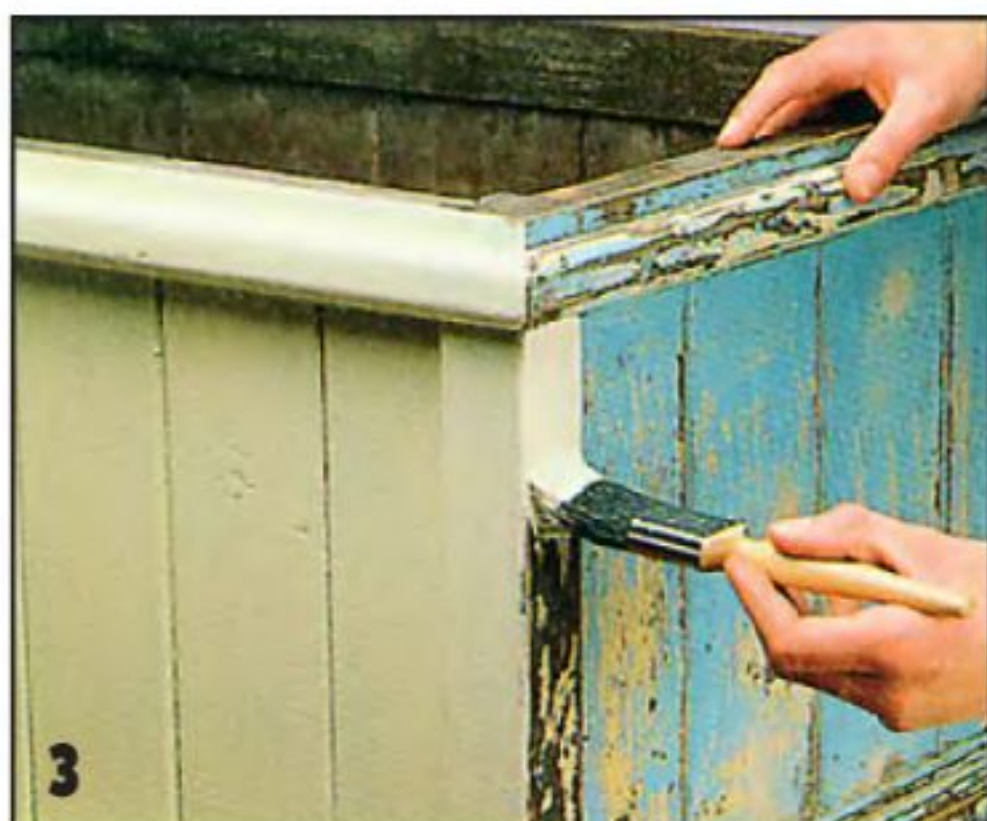
3 На поверхности ящика наносят в один слой грунтовку.
