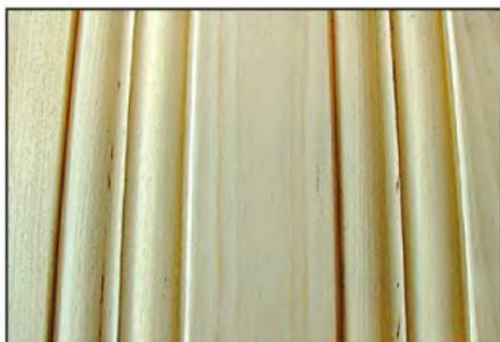
в) так выглядит облицовка из панелей ПФ-15 и ПФ-16, уложенных поочерёдно;
