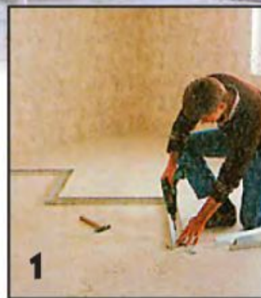
1 Размечают на полу зигзагообразную линию, по которой будет возводиться перегородка, и по разметке прикрепляют к полу шурупами П-образные профили.
