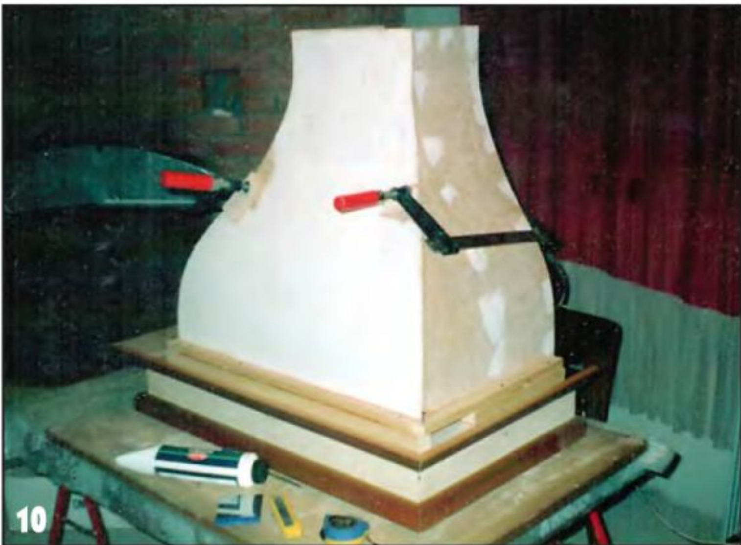
Стыки фанерных стенок проклеиваем серпянкой, а затем шпатлюем и шлифуем поверхности под покраску.
