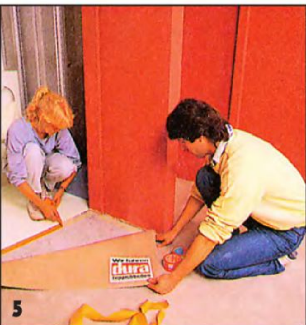
5 Керамическая плитка имеет почти такую же толщину, как и ковровое покрытие. Поэтому переход между этими покрытиями будет плавным. Ковровое покрытие приклеивают к основе двусторонней клейкой лентой.
