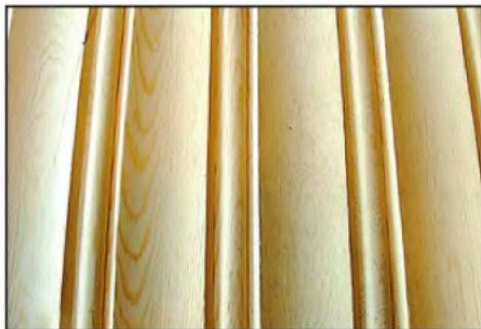
а) так выглядит стена, обшитая только панелями ПФ - 10;
