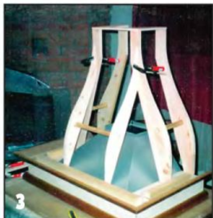
Собираем задуманный деревянный каркас, который позволит потом придать элегантную форму этой вытяжке.
