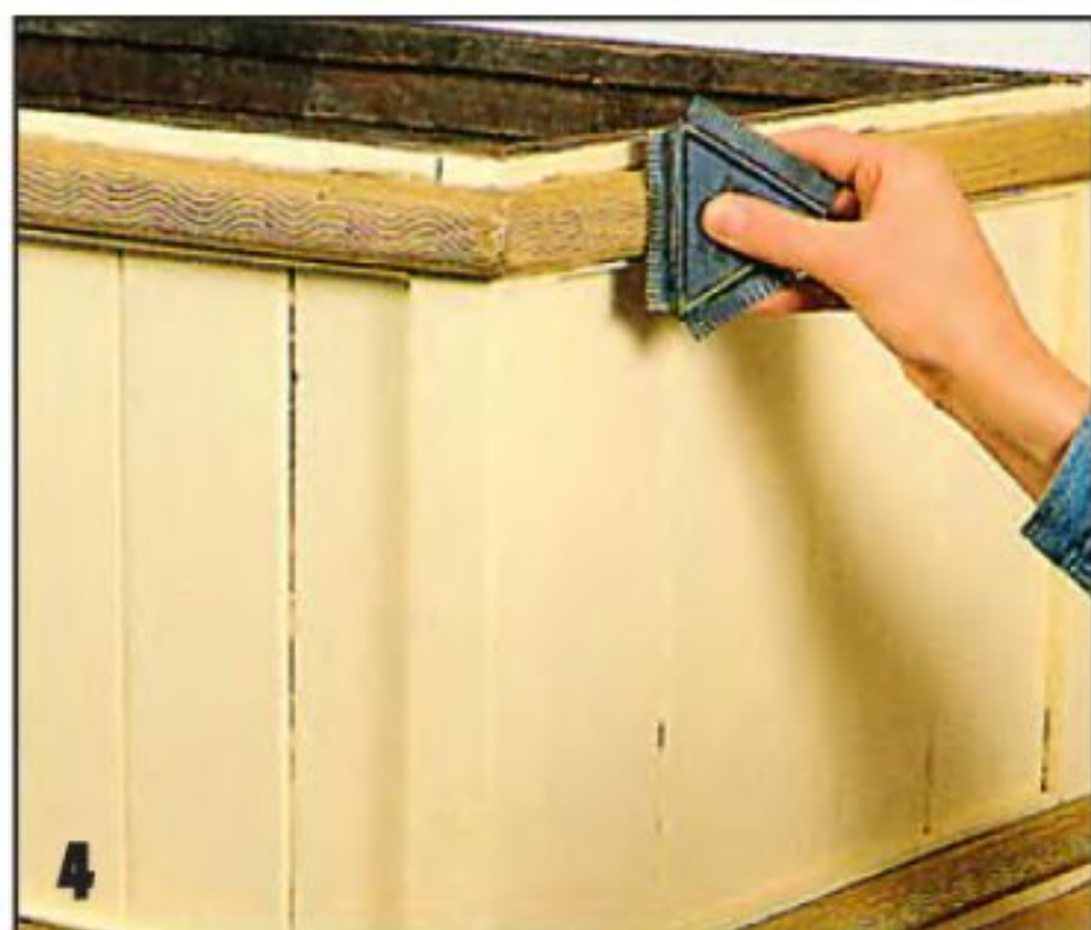
4 Волнистые линии создают зубья пластикового гребня.
