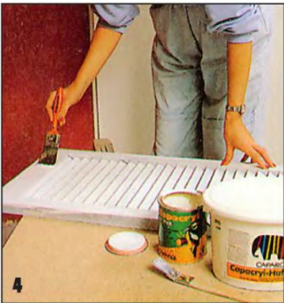
4 Пластинчатые двери покрывают в два слоя акриловым лаком. После завершения работы кисти от лака промывают водой.
