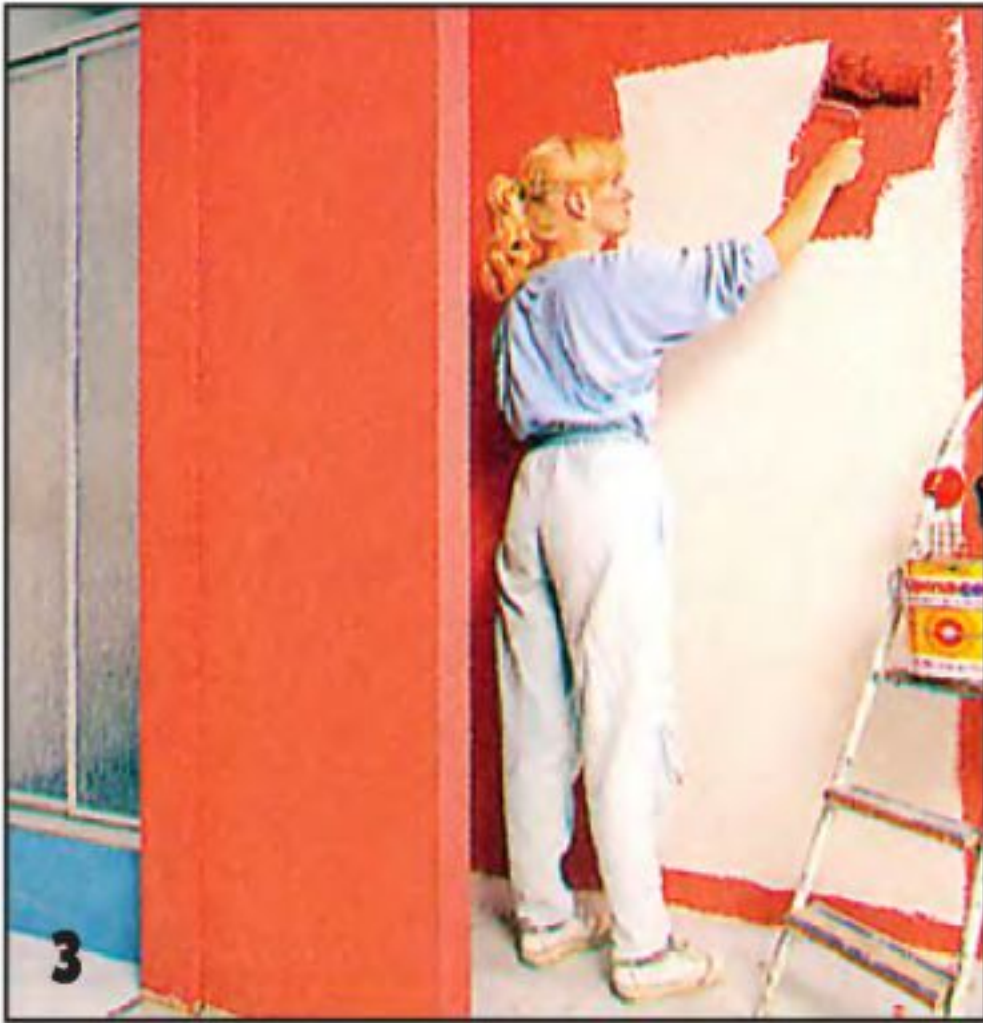
3 При желании использовать нишу в качестве встроенного шкафа или гардероба её внутренние стены окрашивают стойкой нестираемой краской.
