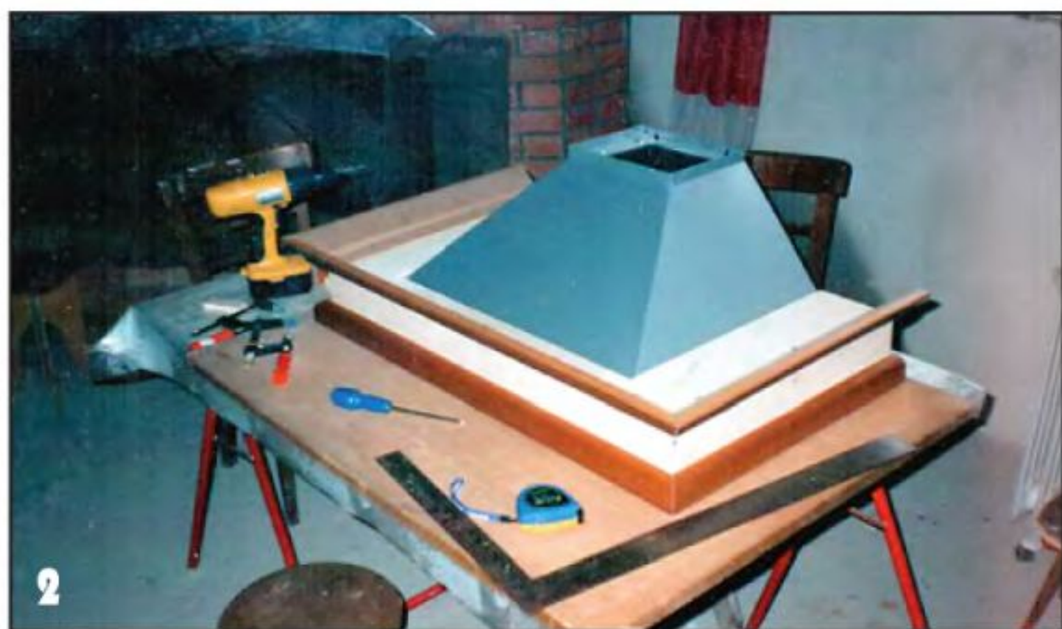
Обрамляем портал багетной и угловой планкой фабричного производства.
