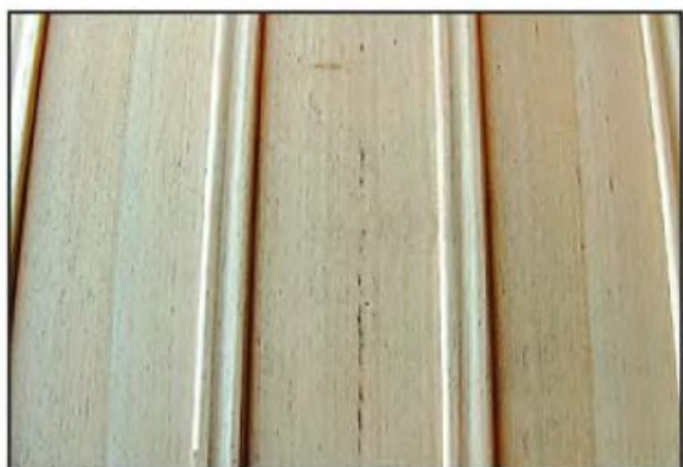
б) обшивка выполнена панелями ПФ-14 с использованием профильных планок;
