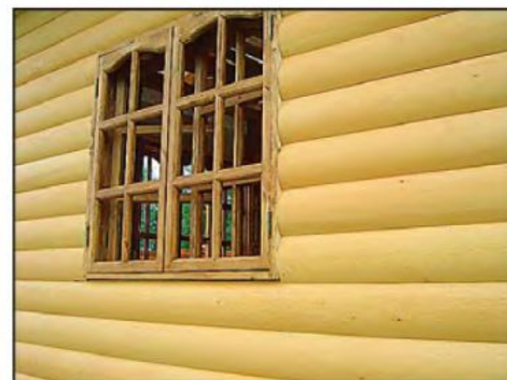
Стены, обшитые блок-хаусом, выглядят сложенными из брёвен.
