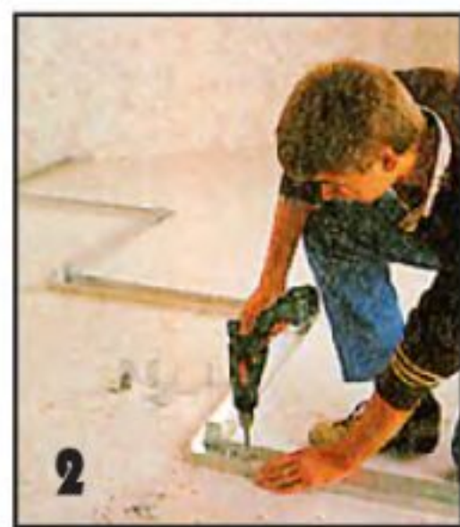
2 В точках поворота уложенных по полу профилей крепят по два стальных уголка, причём так, чтобы к ним можно было потом плотно подогнать деревянные стойки.
